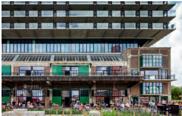
Fenix, Rotterdam Foto: Marc Goodwin
